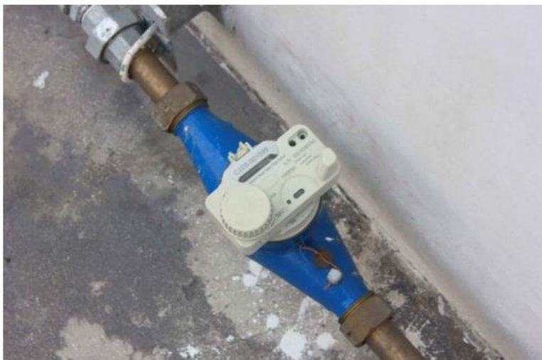
Smart Water Meter สำหรับวัดปริมาณน้ำ และสามารถส่งสัญญาณ LoRa ไปยัง Gateways
